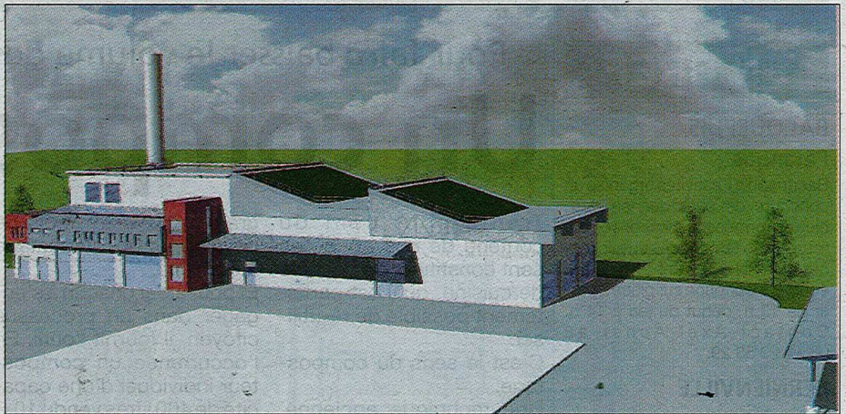
La chaufferie bois s'intégrera aux autres équipements du site d'ECOVAL.
